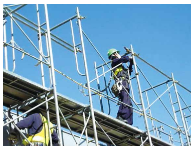
あ し ば か い た い 足場解体
