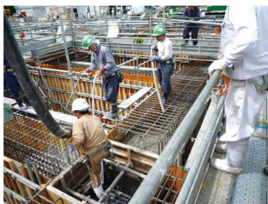
だ せ つ コン打設
