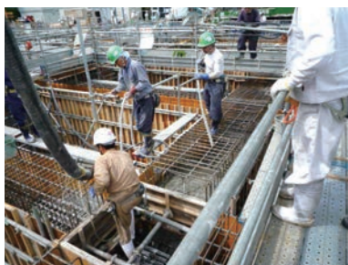
だ せつ コン打設
