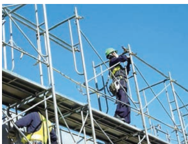
あし ば かい たい 足場解体
